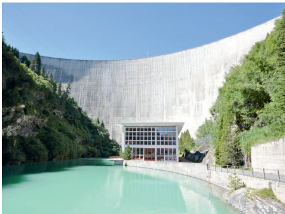
Einnahmen für die Bergregionen. Staumauer der Kraftwerke Zervreila in Vals GR (© Micha L. Rieser)
